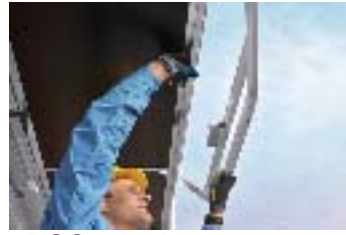
_DSC1600.jpg Einklinken des Sicherheitsgeländers in ein Bordbrett
