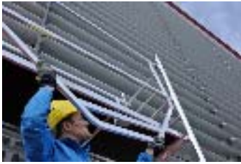
_DSC1604.jpg Auf- oder Abbau von einer rundum gesicherten unteren Arbeitsebene
