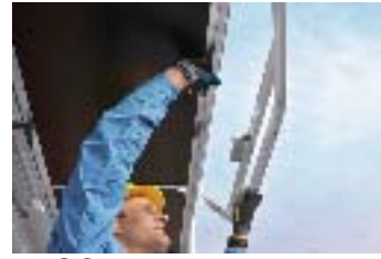
_DSC1600.jpg Einklinken des Sicherheitsgeländers in ein Bordbrett
