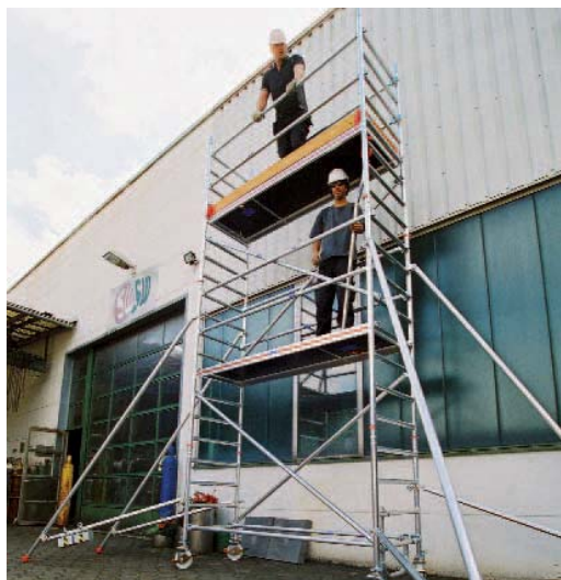
Das fertige Fahrgerüst, komplett mit Bajonettausleger und Umrandung der oberen Ebene zum Schutz vor herabfallendem Werkzeug. (Fotos: PB)
