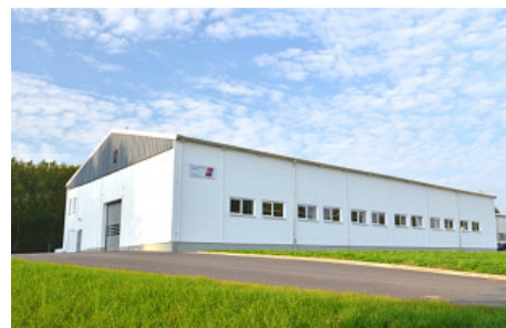
In der neuen Fertigungsstätte von Hymer-Leichtmetallbau auf dem Werksgelände von Capron in Neustadt werden Reisemobil-Komponenten wie Aufbautüren, Stauraumtüren und -klappen direkt vor Ort produziert.
